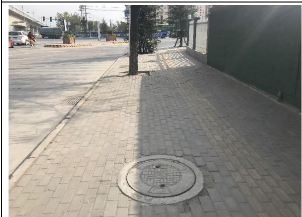
人行道透水砖铺砌工程
